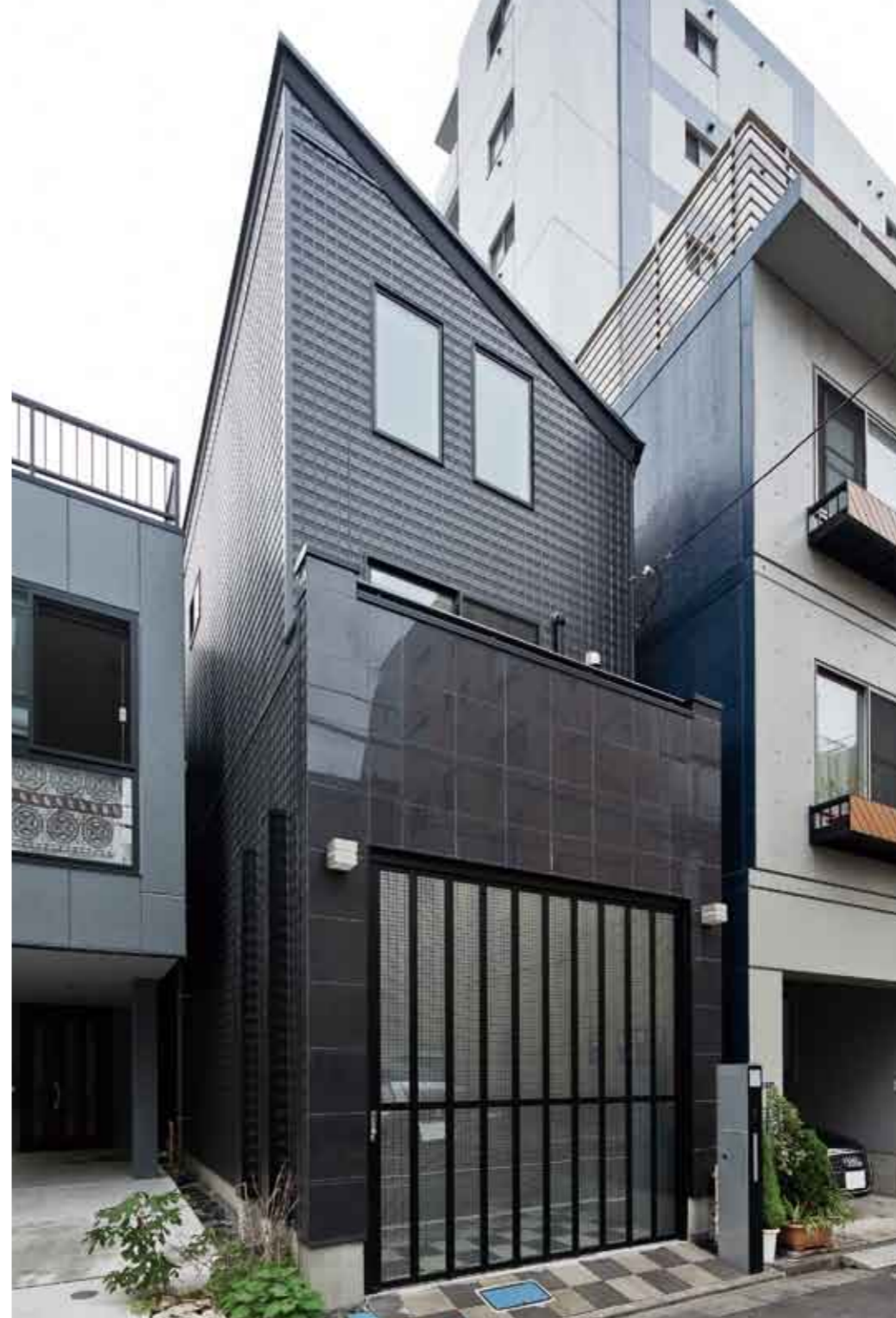
黒一色で統一しながらも、ガルバリウムとタイルという異素材の組み合わせでアクセントを加えたスタイリッシュな外観デザイン。ガレージの側面に見える凸部分は「柱」ではなく「壁」で設計し、高い耐震強度を実現した。「納得の我が家が完成です」とAさんは笑う（台東区A氏邸）
